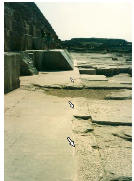
Abbildung 8: Nordkante der GroÙen Pyramide. Deutlich ist im Vordergrund die ziemlich verwitterte Grundkante zu erkennen (Pfeile), die ursprünglich und auch noch zur Zeit Borchardts und Coles einen haarscharfen Verlauf besaß. Im Hintergrund sind noch Original-Verkleidungssteine der untersten Lage zu sehen, deren Unterkante mit dem Grundkantenverlauf auf den Pflastersteinen erwartungsgemäß in einer Flucht liegt.
